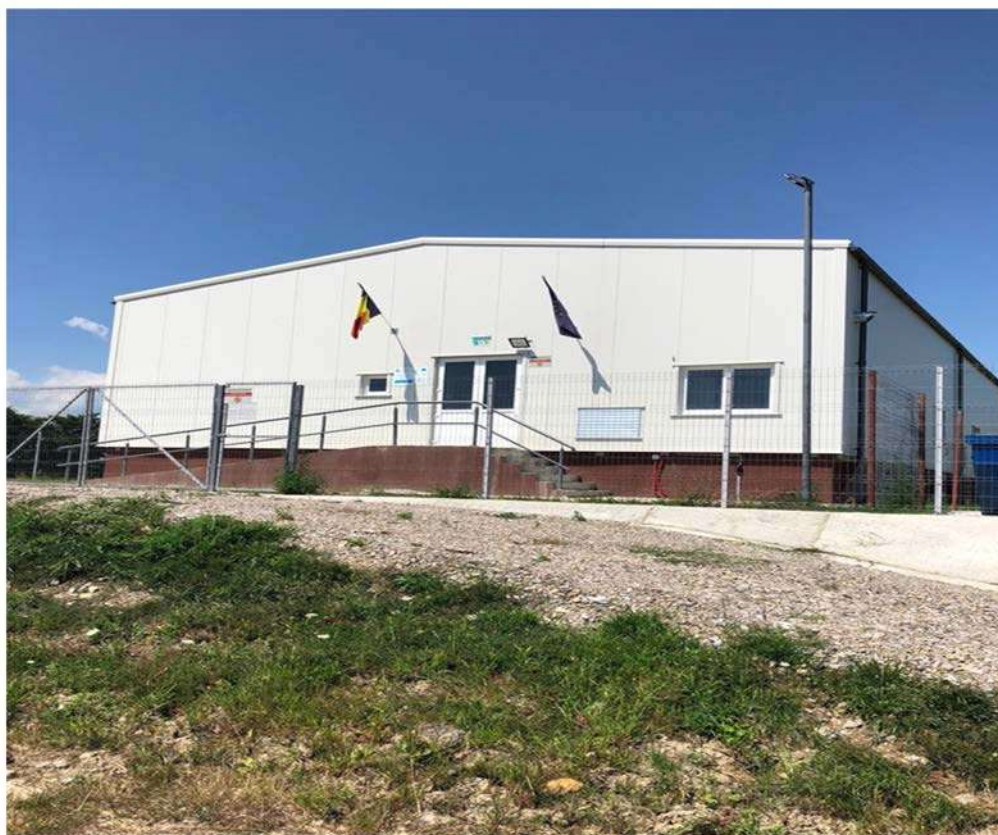
Fotografie 17 – Exterior stație de epurare
