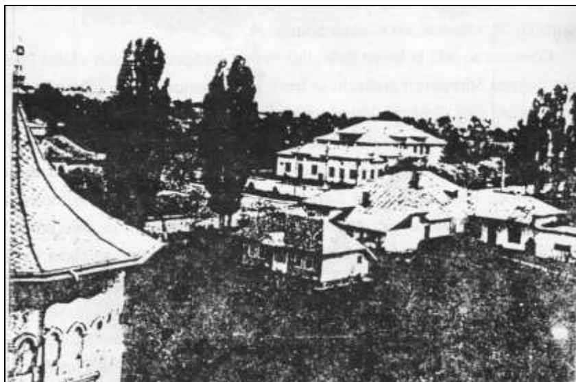
Boroaia. Vedere generală înspre șesul Moldovei
